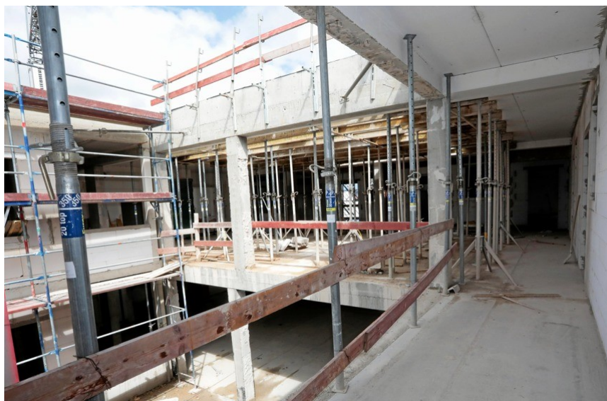
Das Dach des ehemaligen Möbelhauses am Marktplatz wurde bereits aufgeschnitten für den neuen Lichthof. Rechts im Foto lässt sich der spätere Laubengang erkennen, über den die Mieter in ihre Wohnungen gelangen.
